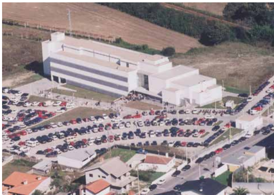
O primeiro edifício construído em 1995
