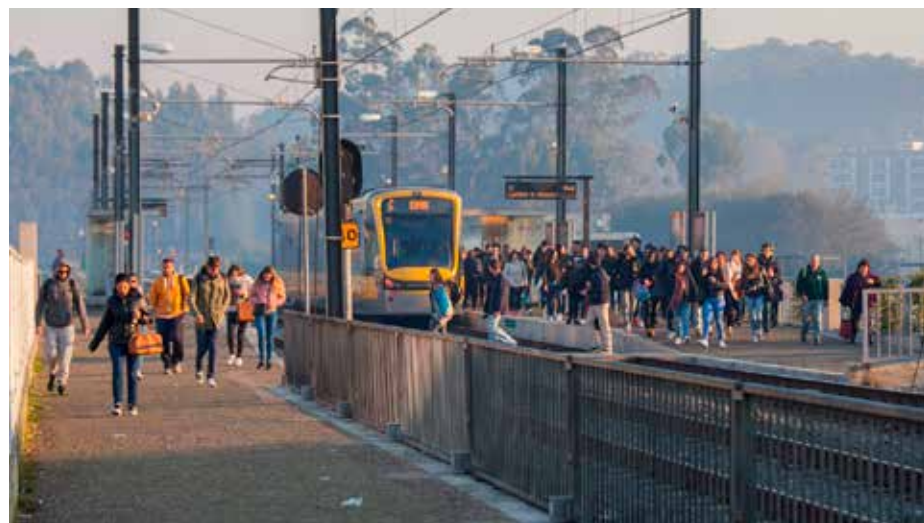
Estação ISMAI (Linha Verde) concluída e ativada em 2006, anexa ao Campus Académico da Maiêutica
